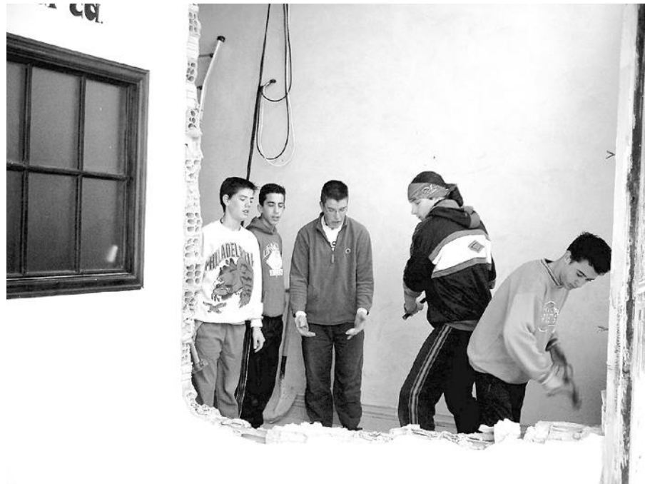
Arriba: Los más jóvenes también ayudan a derribar tabiques en Burgos. Abajo: Entre muchos voluntarios, la obra progresa rápidamente.
